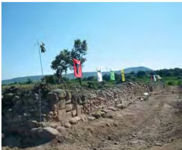
Muro reforzado con sillares de piedra arenisca.
