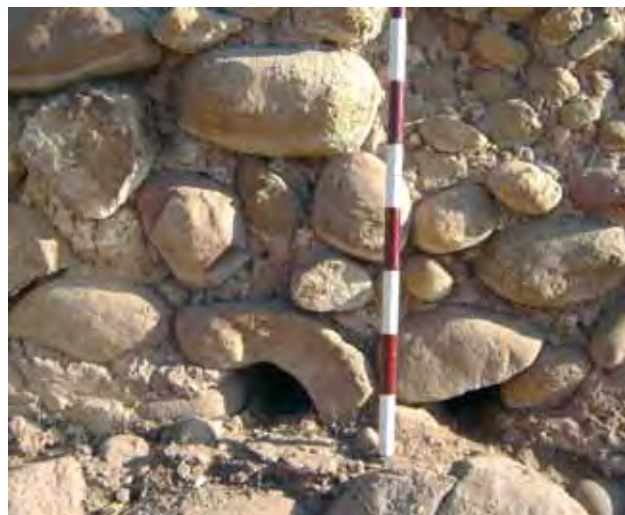
Posibles aliviaderos de las aguas pluviales.
