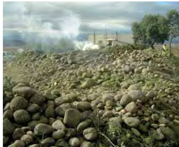
Estado del hospital de San Antón antes del Campo de Trabajo.
